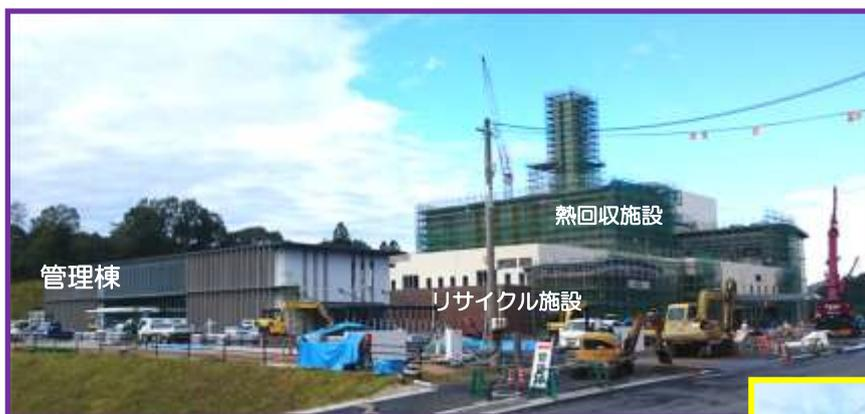
建設工事敷地の南側からの状況です。煙突や本体施設の外壁工事も概ね出来上がり、塗装工事が完了次第、足場の解体を順次行っていきます。
