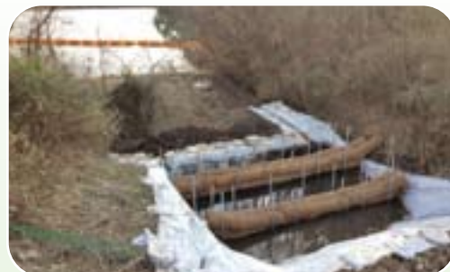
濁水対策工事の様子
