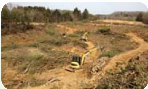
樹木伐採工事の様子
